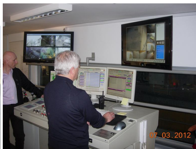
Prostorija u kojoj se kontroliše kompletan proces biorazgradnje u postrojenju za kompostiranje
