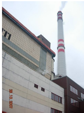
* Dimnjak u spalionici visok 170 m
