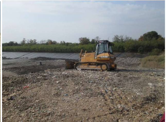
Tretman prethodno neiskorišćenog dela komunalnog otpada na sanitarnoj deponiji
