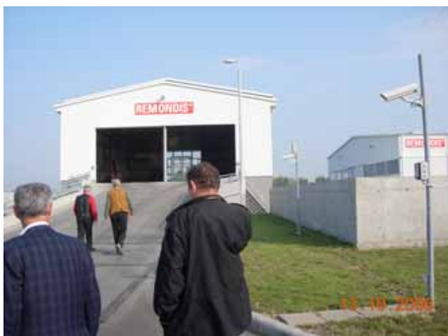
Ulazna dvokanalna platforma ispred Transfer stanice
